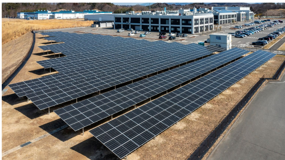
福島県環境創造センターに設置した太陽光発電所
