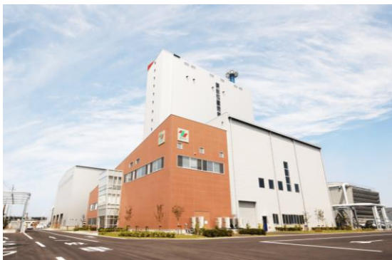
【秋田バイオマス発電所：秋田県】
