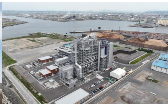
【石巻ひばり野バイオマス発電所：宮城県】
